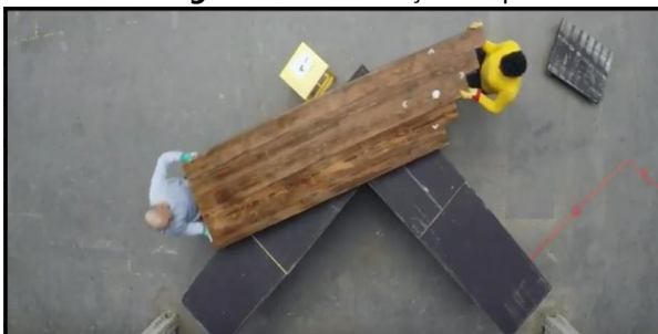
Figura 7 - Construção de ponte
